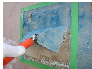
塗膜はく離作業 使用工具：刃付スクレーパー
