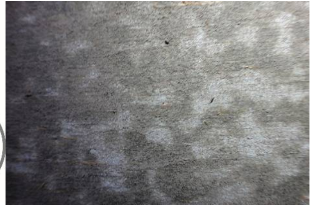
試験箇所: 1階 東側 外壁面 ① 塗膜はく離作業完了状態 躯体凹部に残存する塗膜の状態 (残存: 白色部)
